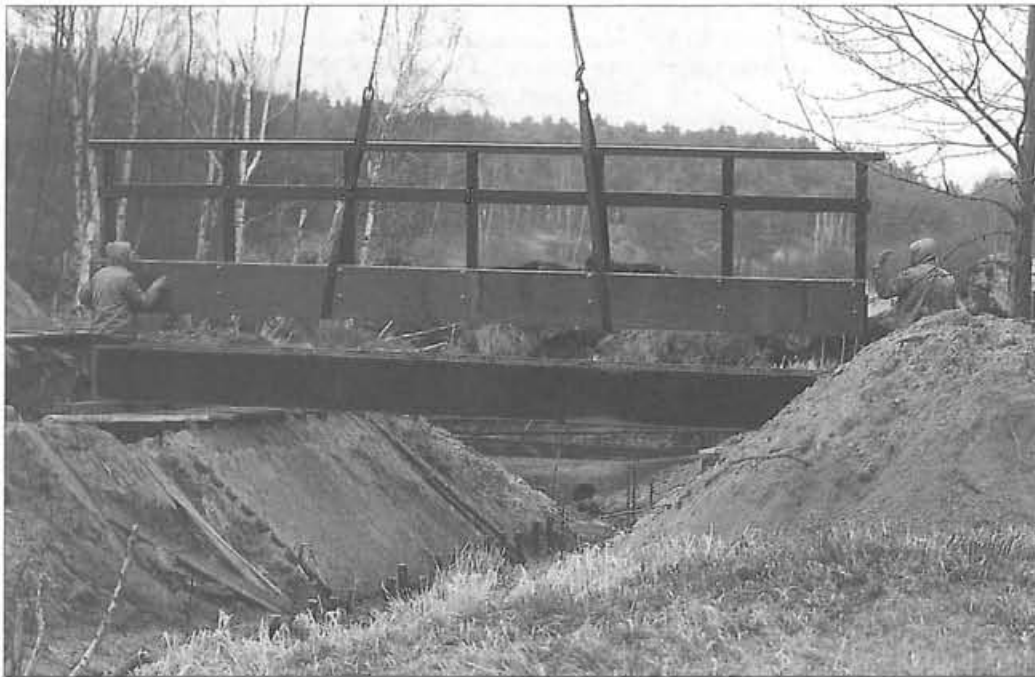
Die vorgefertigte Holzbrücke über den Pfeffergraben wurde innerhalb eines Tages montiert.
