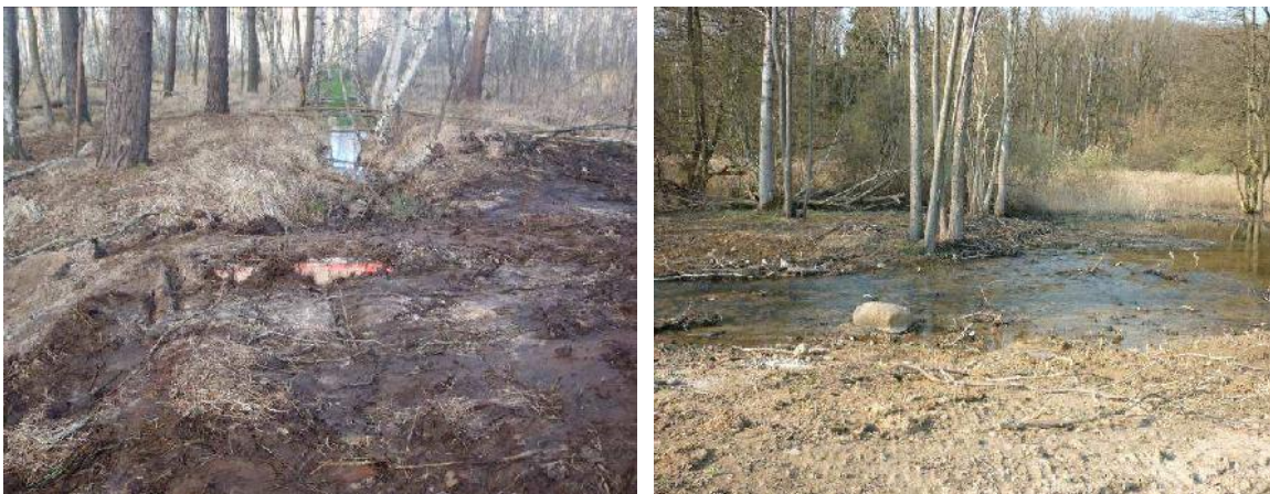
Abbildung 18: links - Grabenplombe mit Pfähreihe (Niederlausitz), rechts - Sohlaufhöhung durch Reisigpackung (Förderverein Feldberg-Uckermärkische Seenlandschaft).
