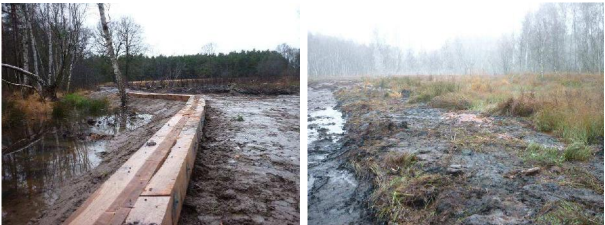
Abbildung 17: links - Stulpwand zur Abdichtung eines Entwässerungsgrabens in einem Quellmoor. rechts - Grabenverfüllung mit Material aus eine Flachabtorfung (beides Naturpark Niederlausitz).
