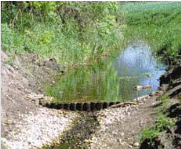
Bei geringem Wasserstand verhindern Bodenschwellen das vollständige Abfließen des Wassers aus den Flachwasserseen bei Stangenhagen. Foto: P. Koch
