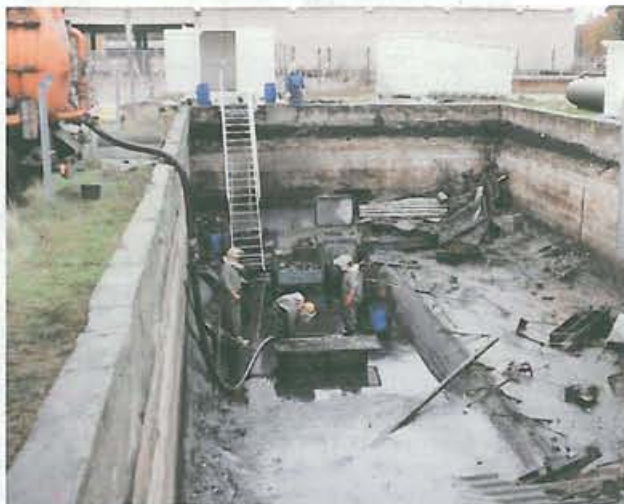
Zum Himmel stank, was als Ölabscheider und Sammelgrube für Oberflächenwasser gedacht war: Ein (nahezu beräumter) Müll-Cocktail auf ehemaligem Militärgelände.
