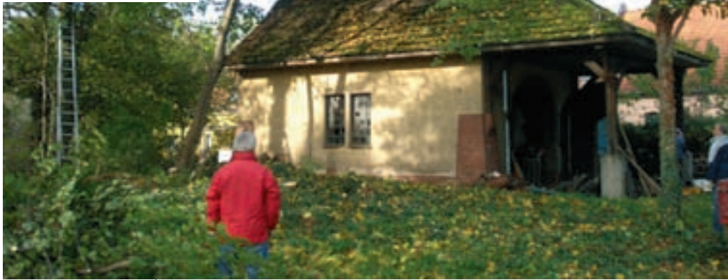
Aufräumarbeiten auf dem Gelände der Alten Gutschmiede (oben)
